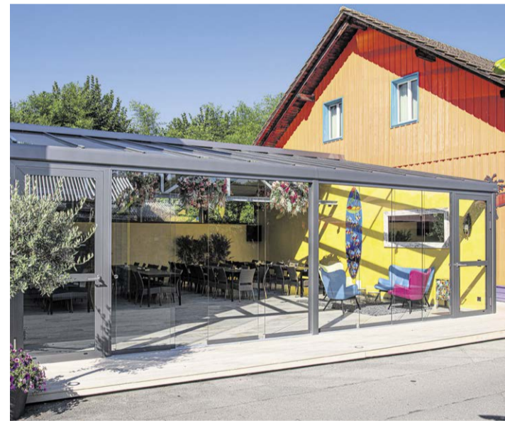
Referenzobjekt Metallbausysteme: Das Caribbean Village der Beachbar Nottwil.
