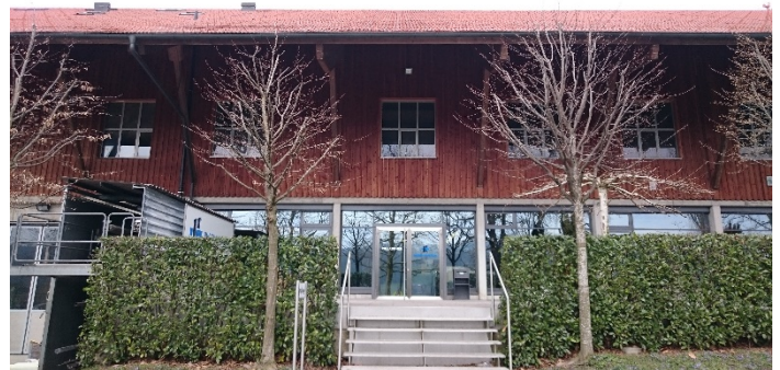
Haupteingang Huber Kontech
